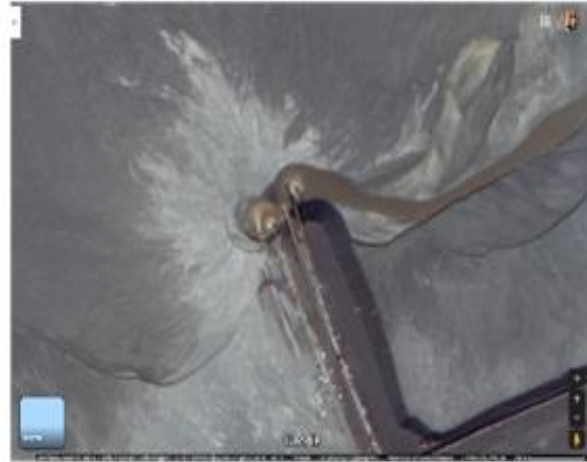
Жидкие отходы (труба оборотной воды)
