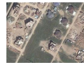
Строящийся коттеджный поселок
