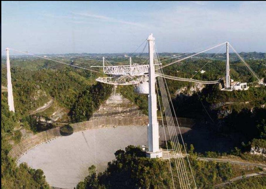
Вид антенны радара некогерентного рассеяния (430 МГц) в Arecibo (Puerto Rico). Диаметр зеркала антенны 305 м
